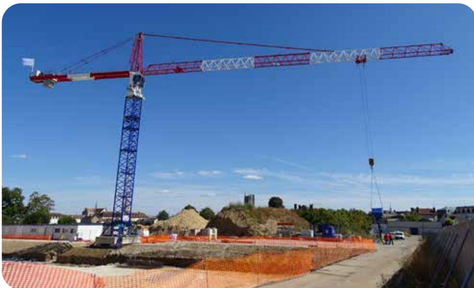
La grue a été installée dès le 25 août.
