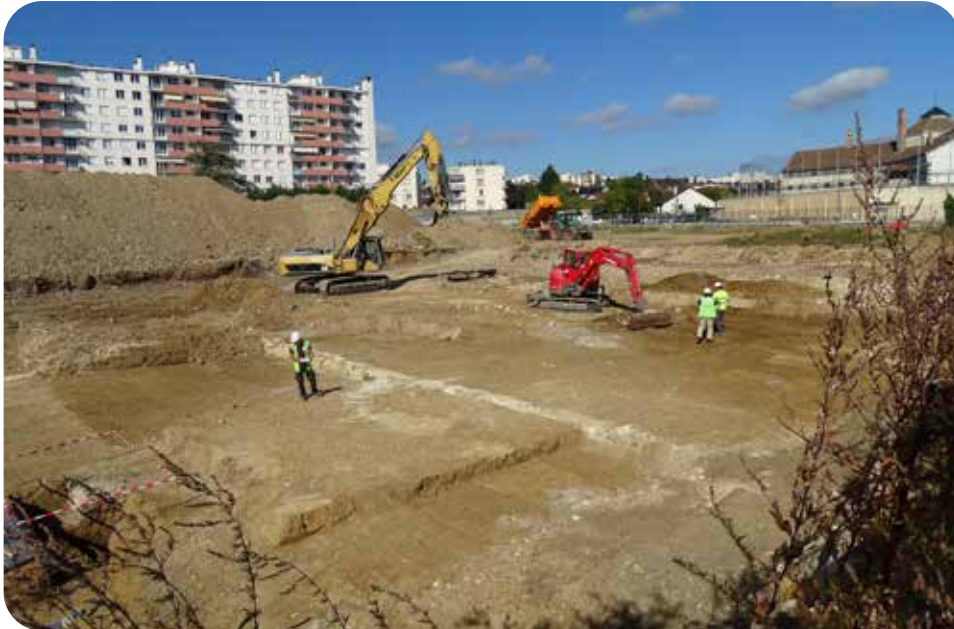
Les premiers coups de pelleuses ont été donnés le 15 juillet.
